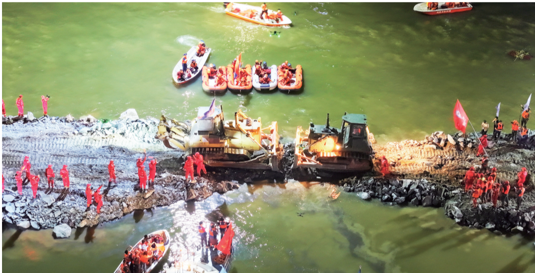
这是7月8日晚拍摄的团洲垸洞庭湖大堤决口封堵现场(无人机照片)。 新华社发
