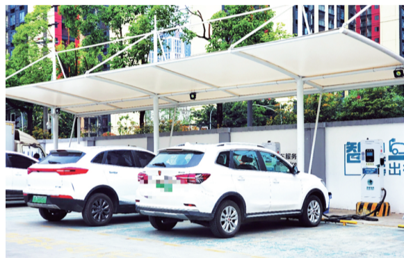
新能源充电站
